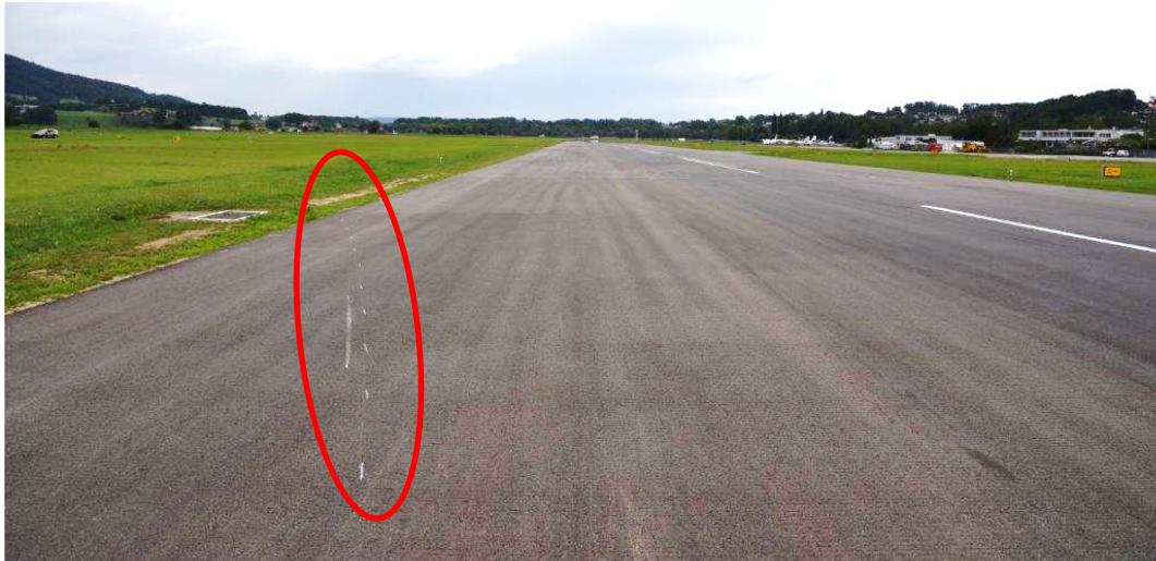
Abbildung 2: Spuren des Kontakts des äussersten Endes der linken Tragfläche mit dem Pistenbelag
