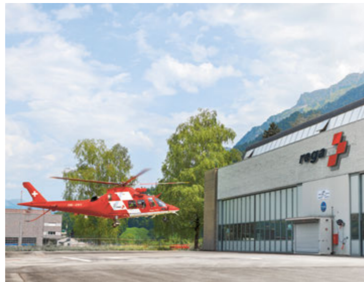
Die Basisinfrastruktur in Wilderswil wurde ausgebaut.
